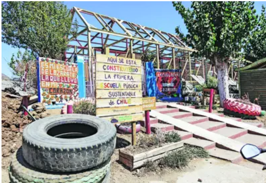
La fachada en construcción de la primera escuela sustentable en Chile
